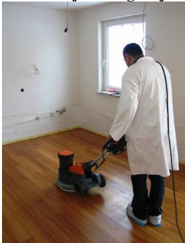
slika 1: strojno nanašanje olja z enokolutnim čistilnim strojem
